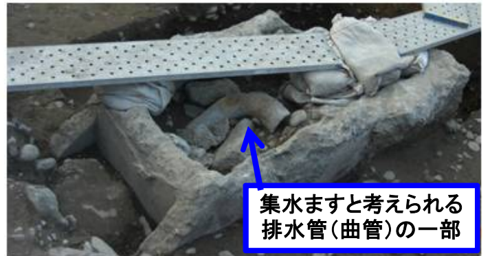
上: 集水ます (推定) 下: 凸型基礎 (推定)
